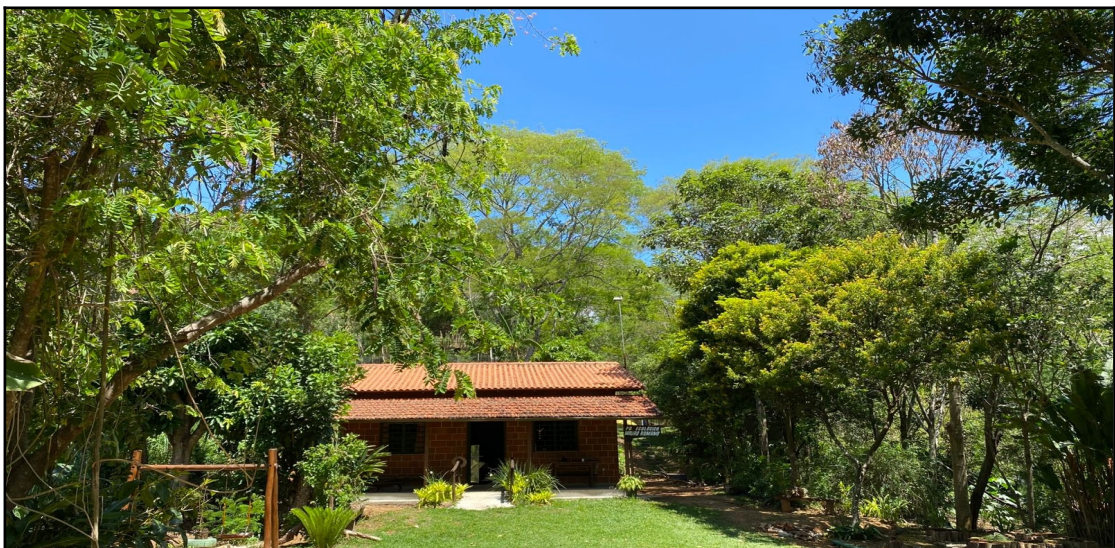
Figura 5. Fachada da sede da Reserva Particular do Patrimônio Natural Mauro Romano, Vassouras - RJ. Fonte: Autoria própria.
