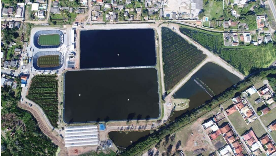
Figura 19. Vista aérea da Estação de Tratamento de Esgoto (ETE) de Ponte dos Leites, Araruama, RJ. Fonte: Águas de Juturnaíba, 2023.
