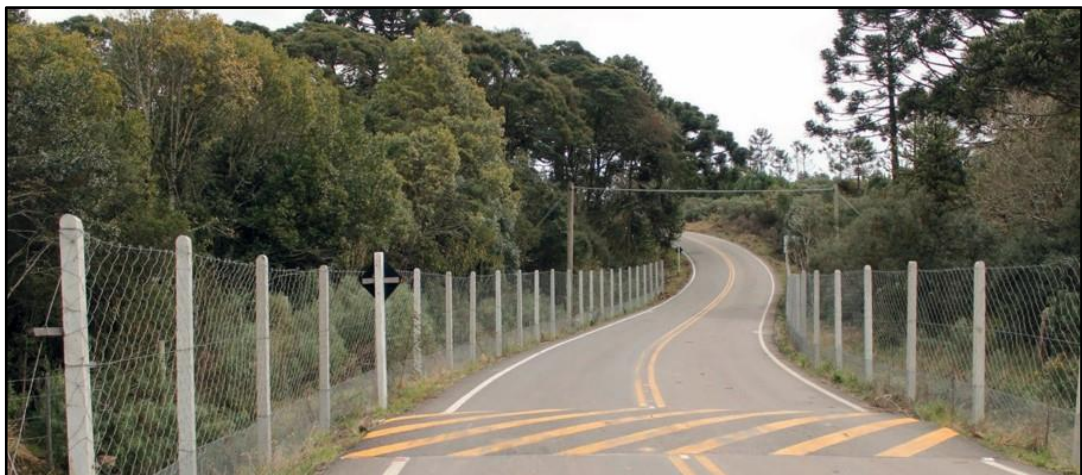
Figura 33. Barreira (cerca) instalada com o objetivo de minimizar atropelamentos de animais por veículos. Fonte: Gonçalves et al. (2023)
