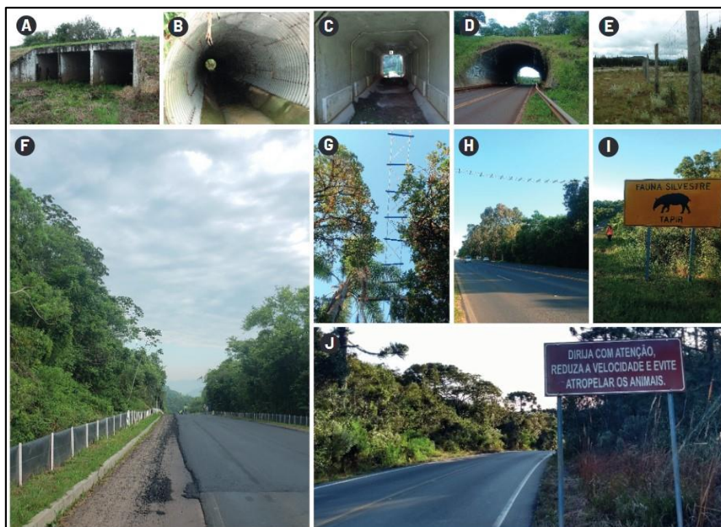
Figura 28. Exemplos de medidas de mitigação: passagens inferiores de fauna (A, B e C), passagem superior de fauna ou viaduto vegetado (D), cercamentos para fauna de grande (E) e pequeno (F) porte, ponte de dossel (G e H) e placas sinalizadoras (I e J). Fonte: Gonçalves et al. (2023)
