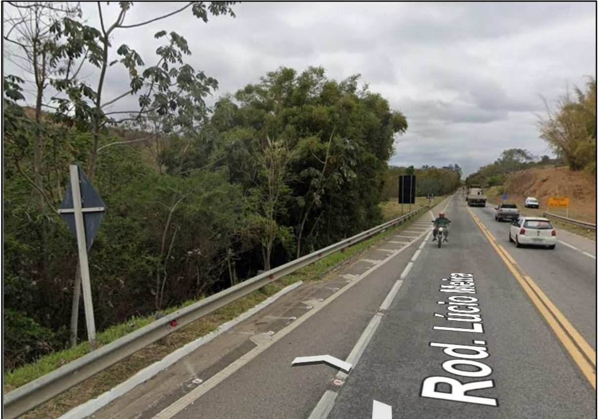
Figura 21. Trecho com presença de gramíneas e vegetação na BR 393 (Rodovia Lúcio Meira). Fonte: Google Earth (2025)
