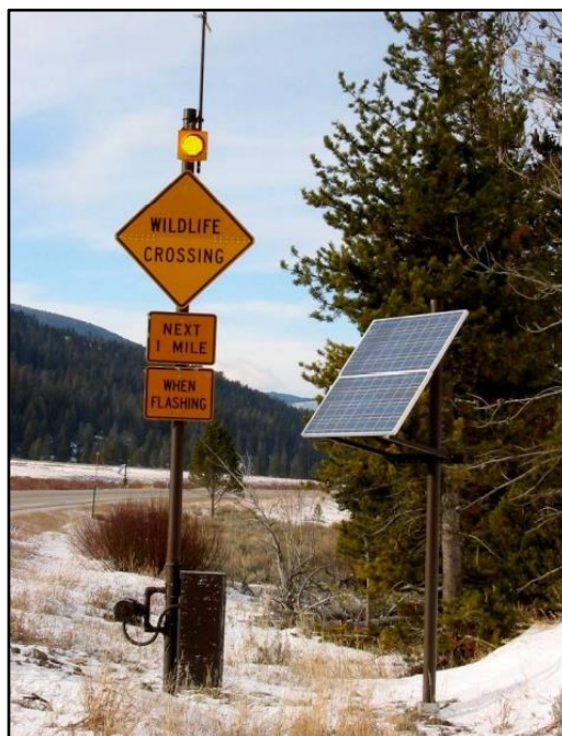
Figura 38. Sistema de detecção de animais no Parque Nacional de Yellowstone, Montana. Fonte: Huijser et al. (2007).
