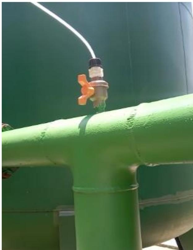
Figura 20: Dosagem adequada de cloro para tratamento bacteriológico (Fonte: Autor, 2023).
