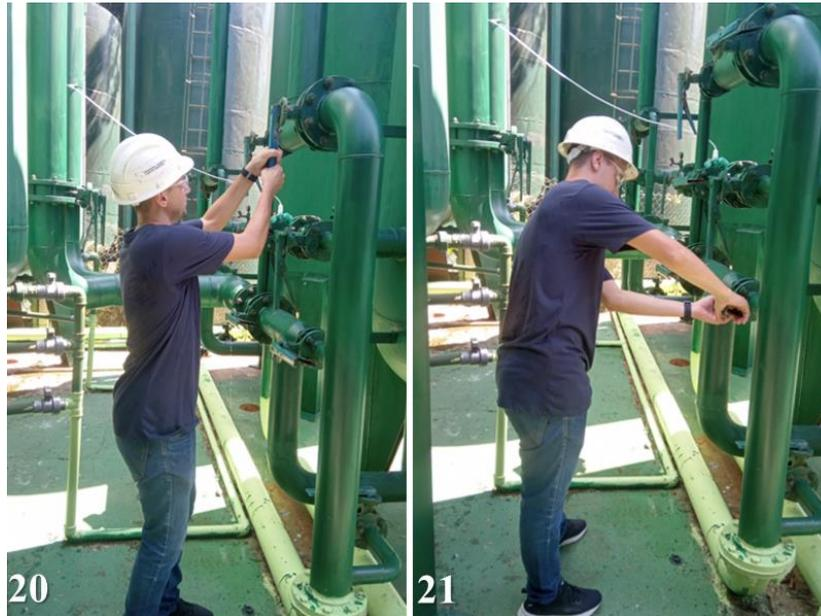
Figuras 21 e 22: Operador realizando procedimento de retrolavagens (Fonte: Autor, 2023).
