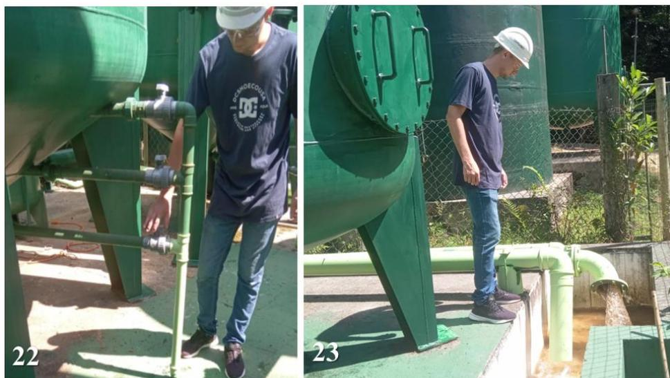
Imagem 24 e 25: Operador realizando a extração do lodo do decantador e acompanhando a extração do lodo gerado na retrolavagem (Fonte: Autor, 2023).
