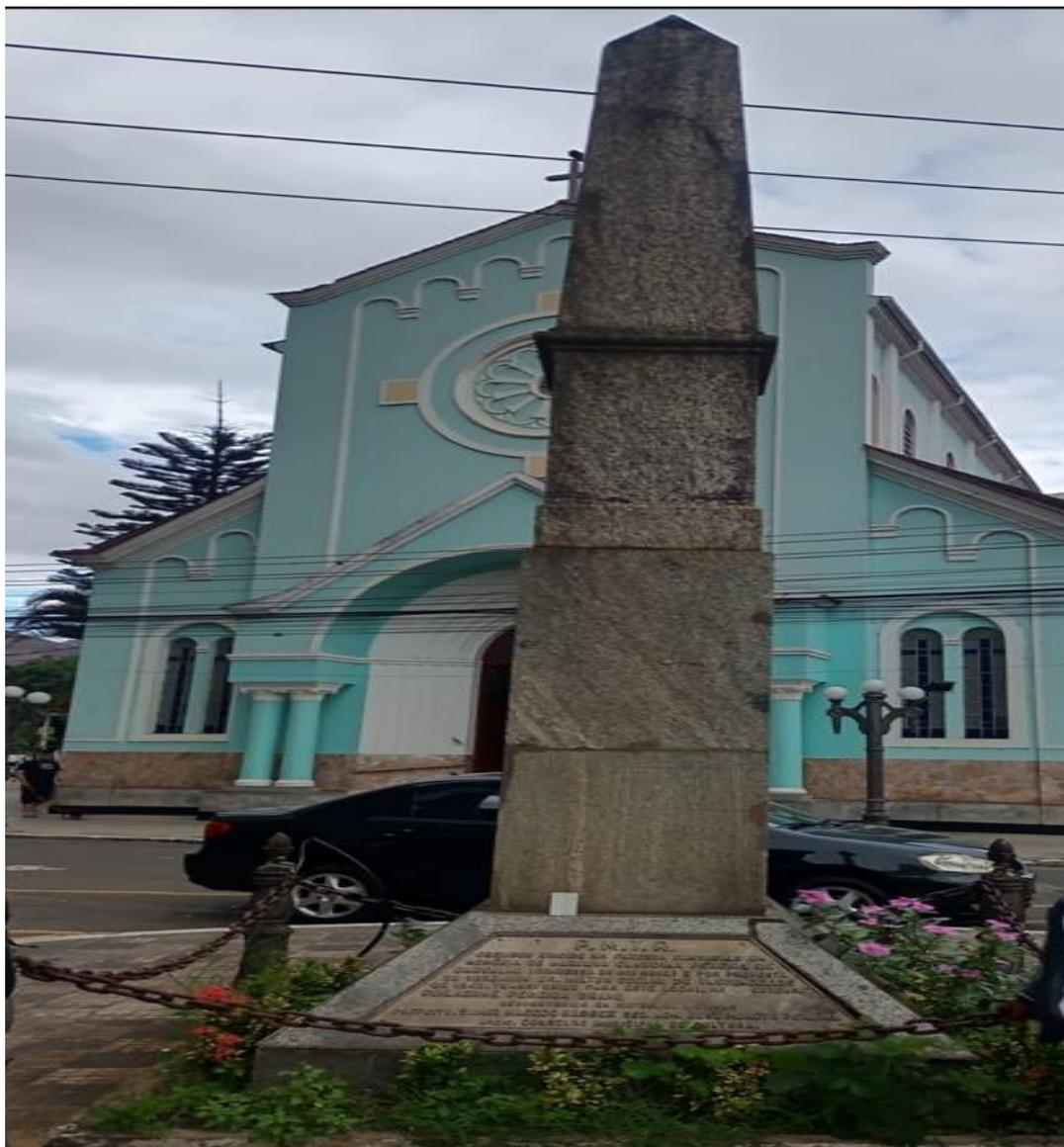
Figura 10: Imagem do Obelisco. Na base observa-se o gnaiss milonítico e o restante do monumento é construído em gnaiss facoidal.
