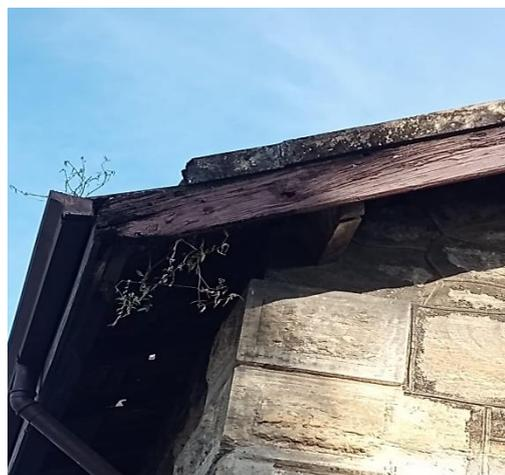
Figura 8: Vegetação e furos no Telhado
