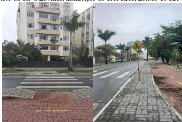
Figura 13. Rampas de acessibilidade (A) e placa informativa (B) no Trecho da Avenida Beira Rio - Alberto da Silva Lavinas, município de Três Rios, Estado do Rio de Janeiro.
