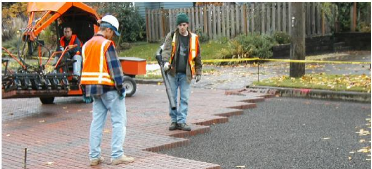
Figura 42. Pavimento permeável. Fonte: Portland Bureau of Environmental Services 2004.
