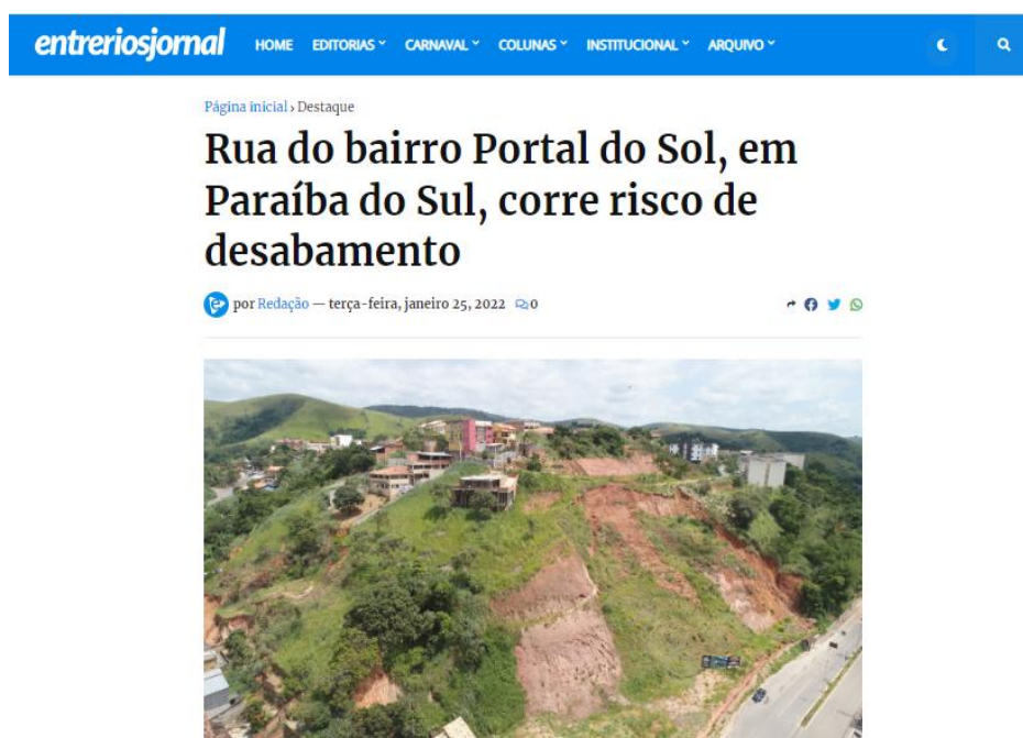
Figura 17. Matéria sobre o risco de desabamento em rua do Portal do Sol em Paraíba do Sul. Fonte: Entrerios Jornal
