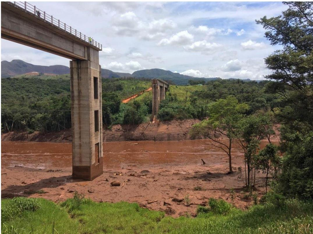
**Figura 10.** Danos à infraestrutura causados pelo rompimento da barragem em Brumadinho, registrado em 26 de janeiro de 2019, Estado de Minas Gerais. Fonte: Venaglia (2019).
