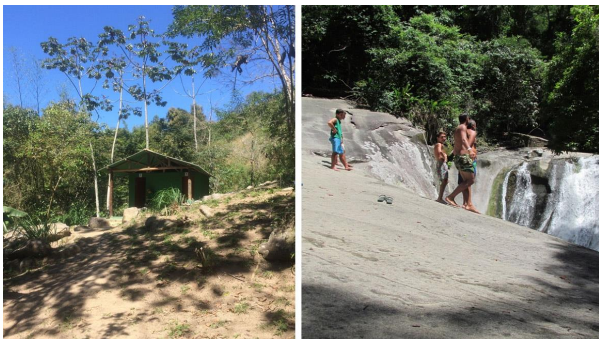
Figura 36 Banheiros instalados na trilha, Sana – Macaé/RJ. Fotografia: Acervo do Autor. Data: 09/09/2018
