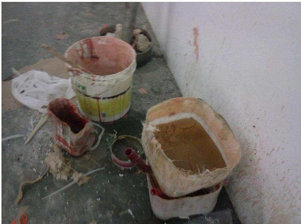
**Figura 10** - Rejeitos de mistura de Resina e fibra de vidro.
