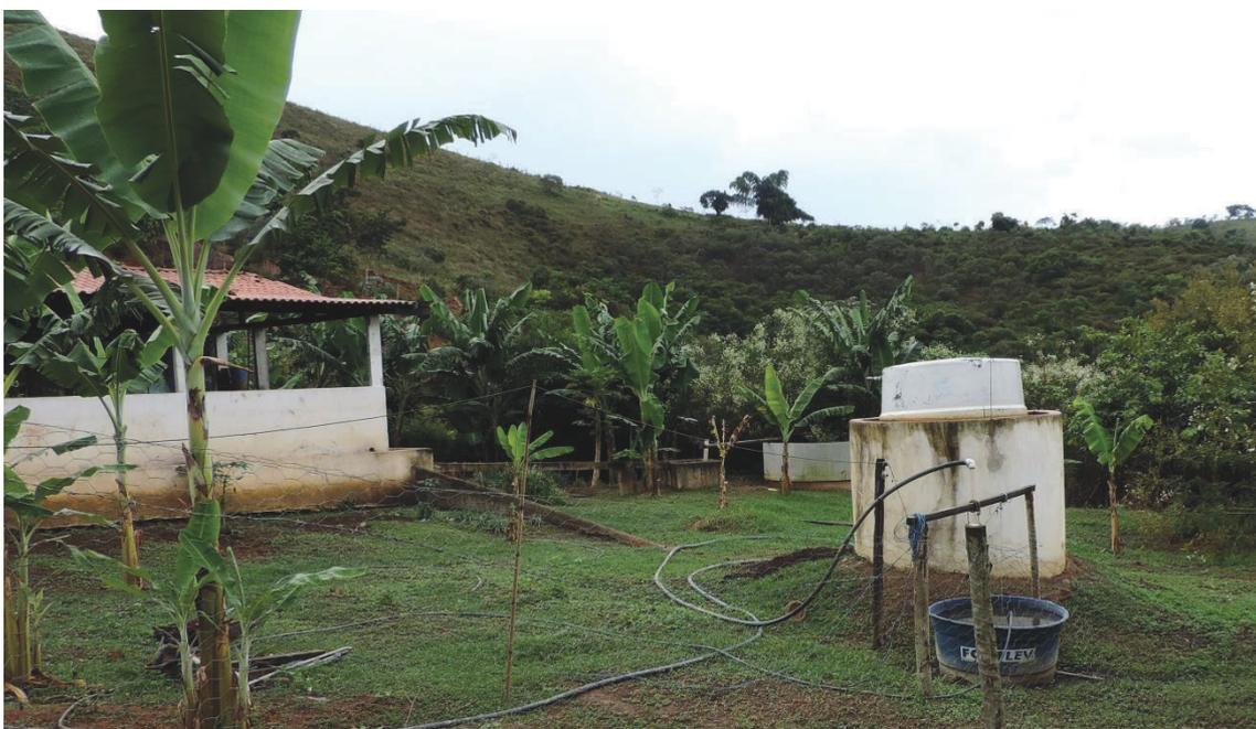
**Figura 9:** Modelo de biodigestor adaptado do indiano, utilizado na propriedade com capacidade de 10.000 L. No detalhe a cúpula móvel.
