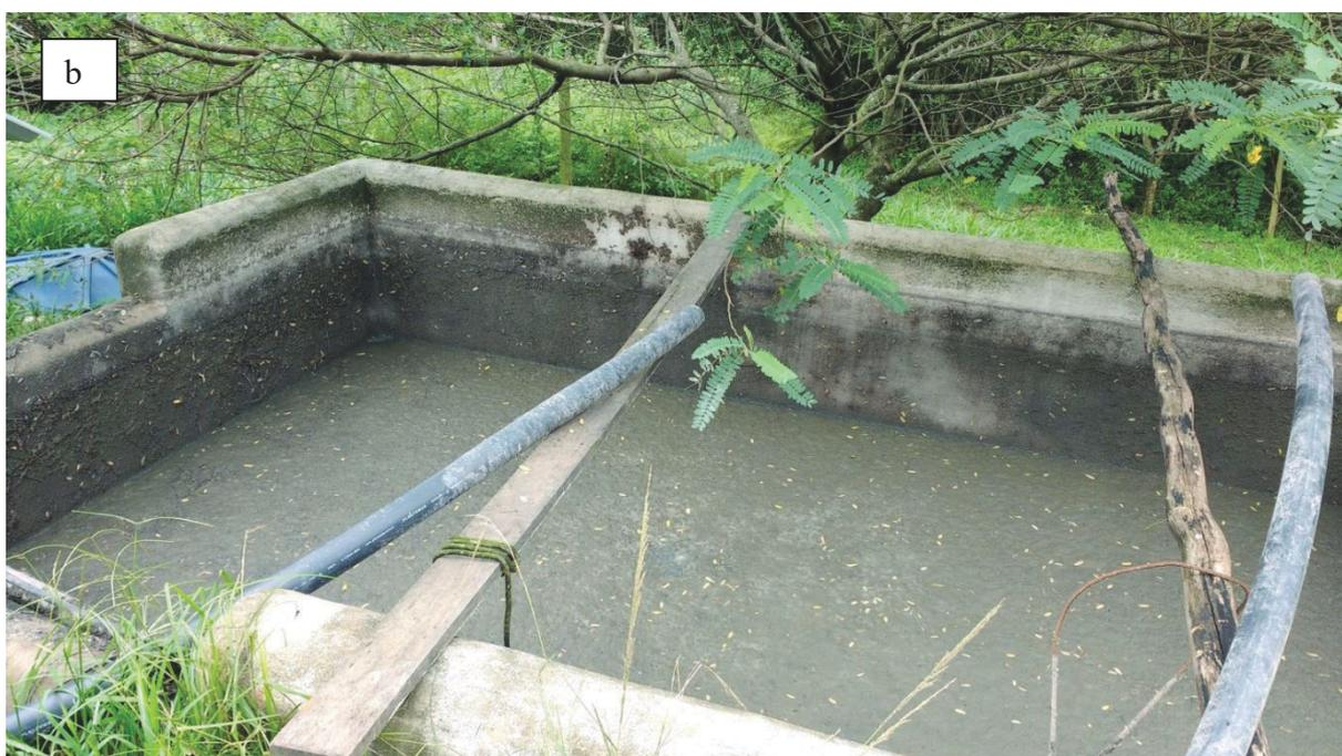
**Figura 8:** Funcionário da fazenda coletando a amostra de biofertilizante bruto direto da caixa de saída do biodigestor (a) e tanque de “espera” diluído com água para pronta aplicação (b).
