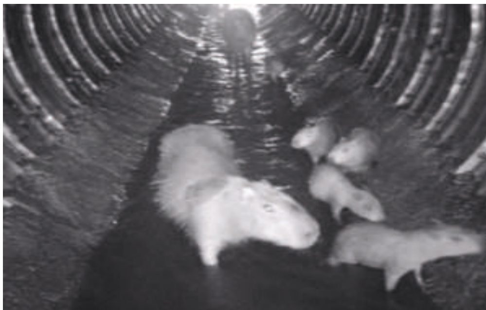
Figura 10. Drenagens de rodovias que podem se tornar funcionais também para a passagem subterrânea da fauna silvestre como as Capivaras da imagem captada por Ely Venâncio. Fonte: https://www.anda.jor.br/capivara-13/ .
