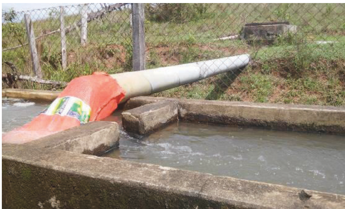
Figura 8. Chegada da água na estação de tratamento desativada. Novembro, 2015.
