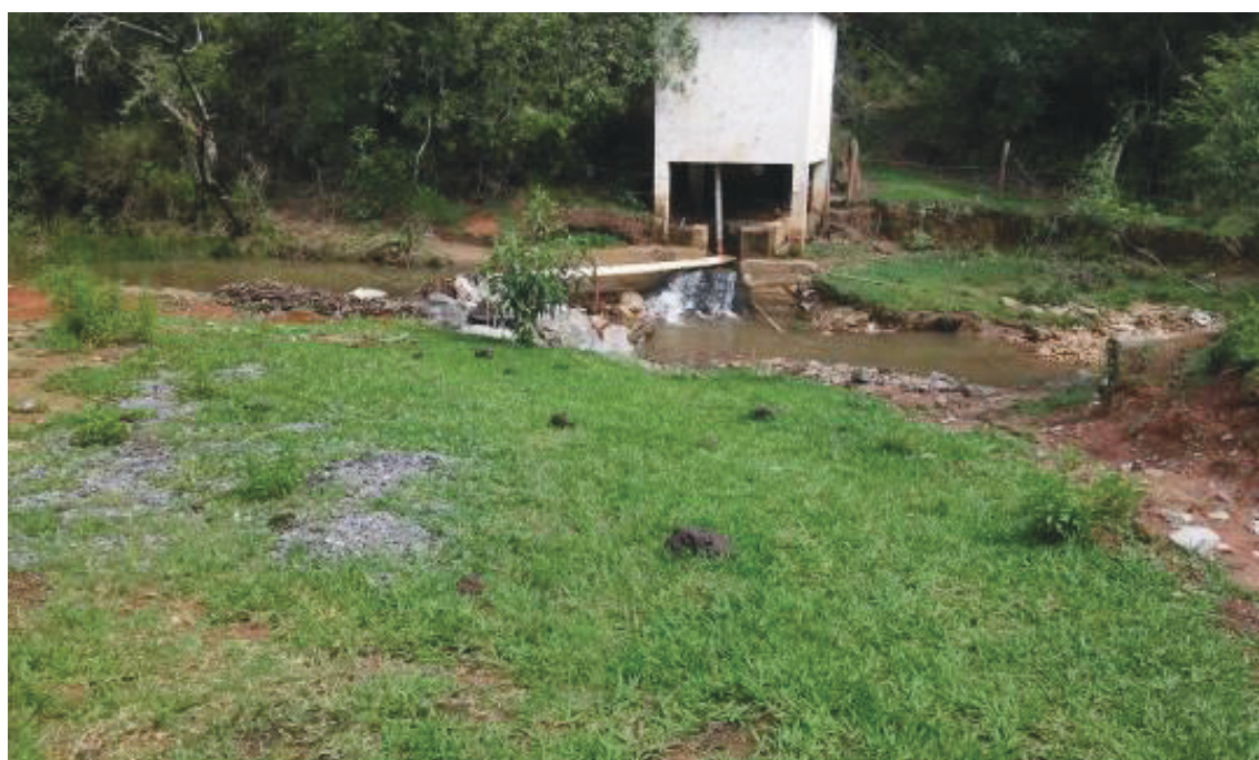
Figura 3. Área de captação hídrica do sistema de abastecimento público municipal em Arantina- MG. Novembro, 2015.
