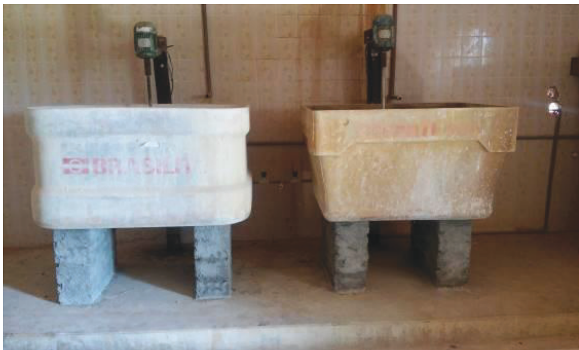
Figura 10. As caixas d'água de amianto eram utilizadas para dosagem química. Novembro, 2015.
