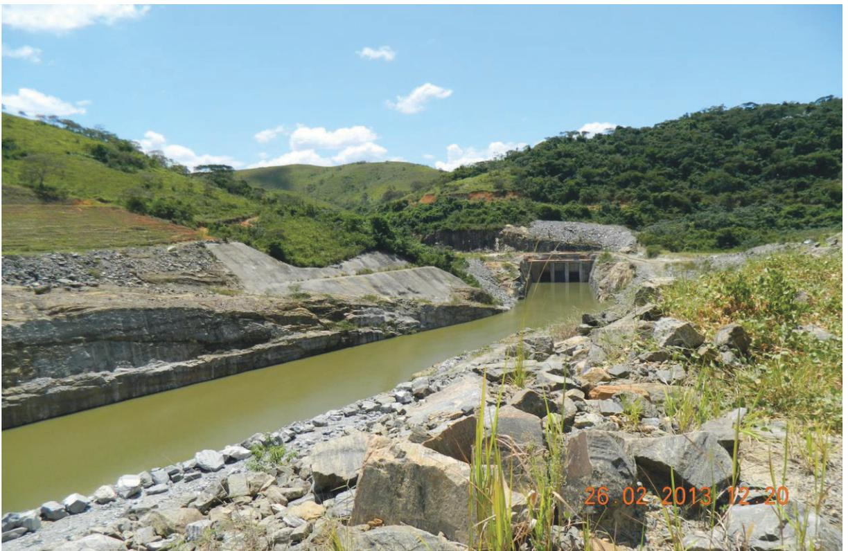
**Foto 6 – Tomada D'água Após o Enchimento do Reservatório**
