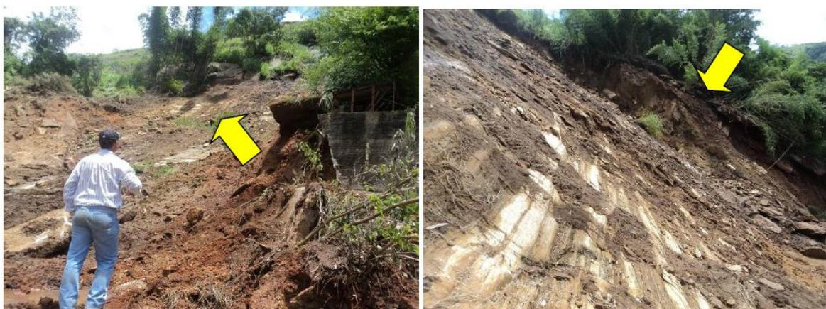
Figura 7– Detalhe dos pontos de inciso da eroso nas ombreiras laterais do deslizamento, que facilitaram o movimento de massa ao descalarem o conjunto de solo e rocha no “sanduíche” da rampa.
