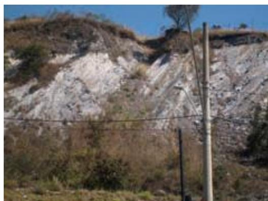
Figura 3- Esquema de escorregamento em cunha (a esquerda) e Talude de filito alternado com quartzito da Formação Cercadinho em Belo Horizonte, MG (a direita). Fonte Parizzi, 2004.
