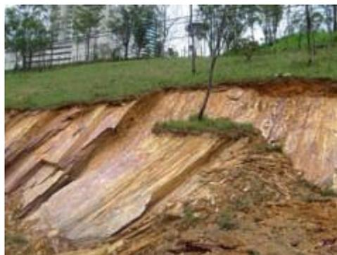
Figura 2- Esquema de escorregamento planar ou translacional de solos (a esquerda) e escorregamento planar em Nova Lima, MG (a direita). Fonte: Parizzi, 2004.
